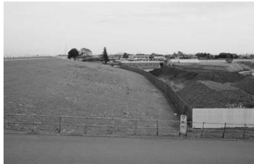
写真8 本川俣でのスーパー堤防造成工事
