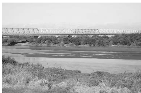
写真10 東北新幹線利根川橋梁
