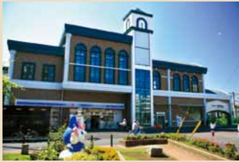
坂戸駅舎外観
