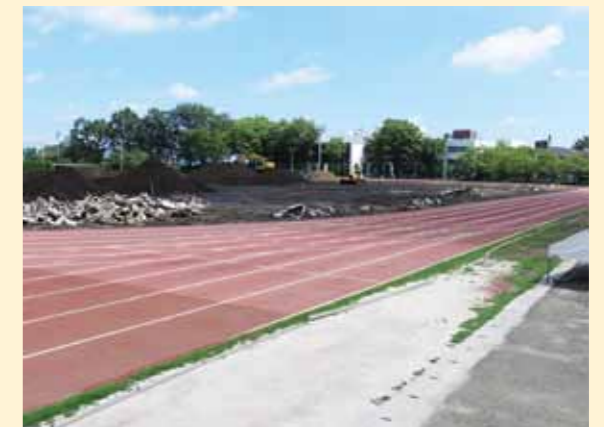
造成中のサッカー場
