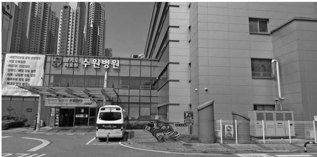
写真7 京畿道立医療院スオン病院建物
