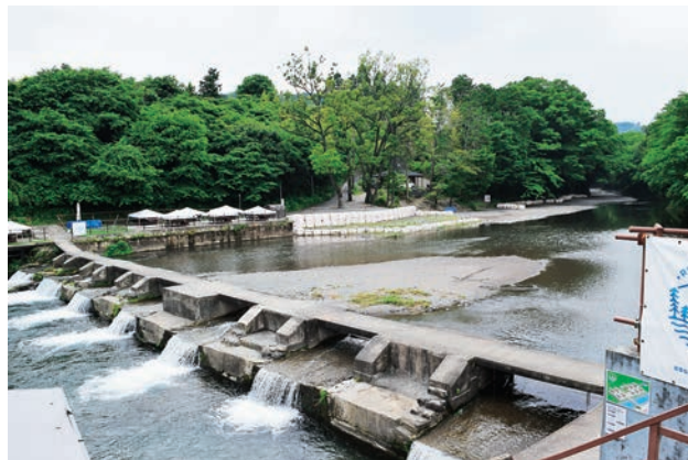
図 7.1 飯能河原の堰の写真 堰は開いている 2022年6月21日撮影
