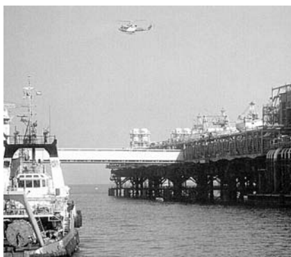
写真3 上部ザクム油田の施設 (国営石油会社が公開した写真)
