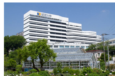
薬学部棟 21号館 (最新の学習・研究設備)
