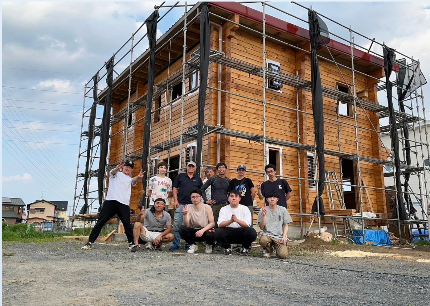
I ログハウス建設
